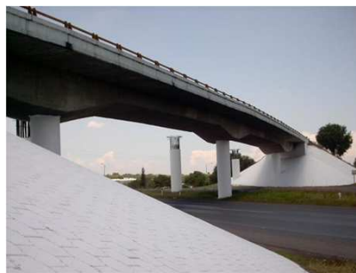
Pintado de elementos de concreto
