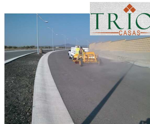
Fracc. San Isidro, Juriquilla, Qro. Limpieza de superficie de rodamiento.
