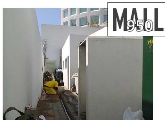
Plaza Mall 950, Querétaro, Qro. Obra civil y señalamiento horizontal.
