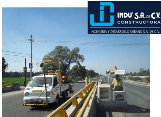
Ampliación Carretera a Tlacote, Qro. Señalamiento horizontal.
