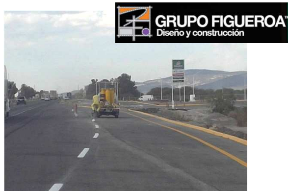
Gasolinera Km 30, Carr. Qro-SLP Defensa metálica y Señalamiento horizontal.
